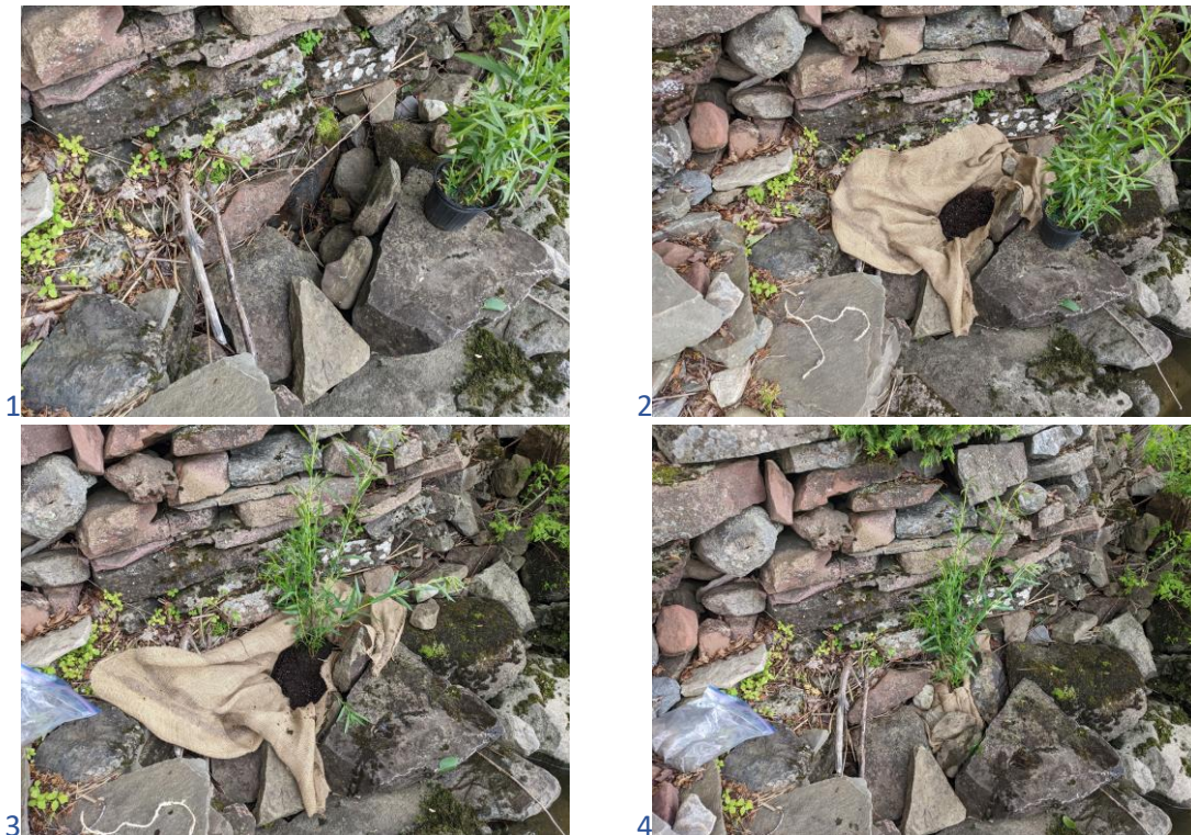
Figure 7: Méthode de plantation en enrochement : 1- déplacer des roches, 2- installer la poche de jute avec la tourbe préalablement humidifiée, 3- installer le plant en s'assurant que la tourbe recouvre tout le système racinaire 4- recouvrir de roches.
