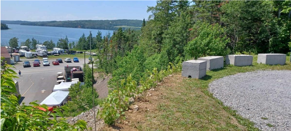
Figure 13: Dessus de l'enrochement, après la plantation au camping KOA, 2023
