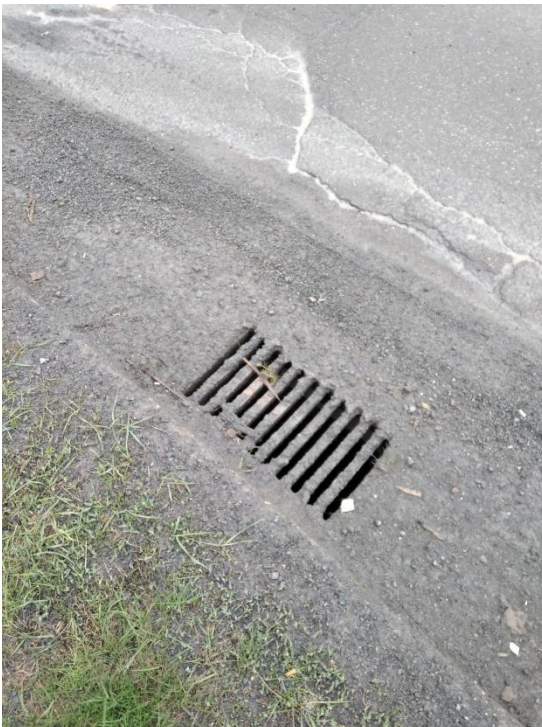
Figure 23. Puisard comblé par les sédiments, 3 mai 2023
