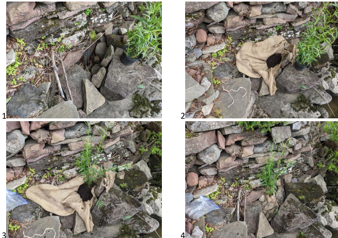
Figure 9. Méthode de plantation en enrochement : 1- déplacer des roches, 2- installer la poche de jute avec la tourbe préalablement humidifiée, 3- installer le plant en s'assurant que la tourbe recouvre tout le système racinaire 4- recouvrir de roches.
