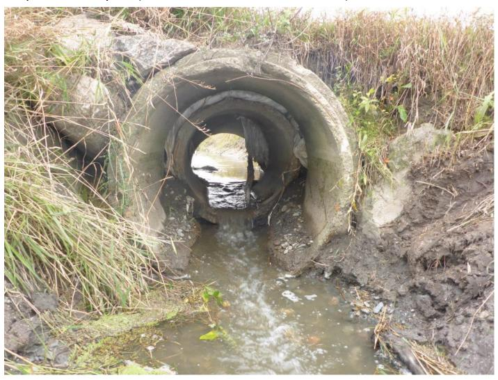
Ponceaux problématiques (réduit la vitesse d'écoulement)
