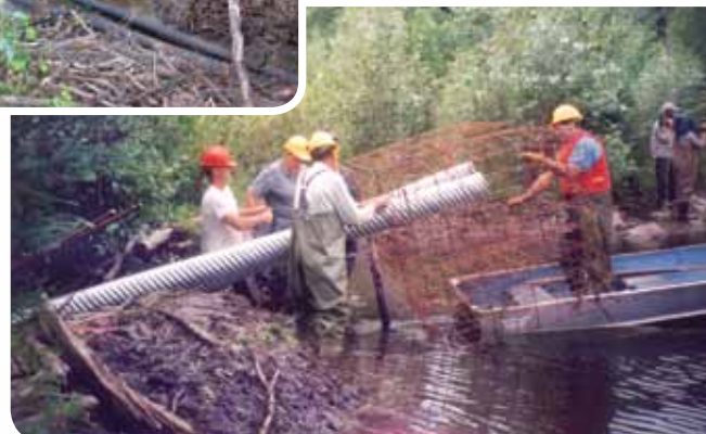
Installation d'un cube Morency Joanne Marchesseault
