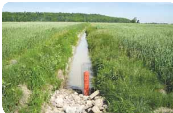
Fossé avaloir « adapté » - Projet ruisseau Richer
