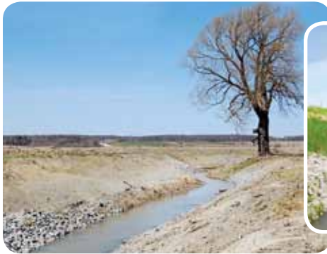
Stabilisation de berge à l'aide d'enrochement, au printemps, peu après les travaux.
